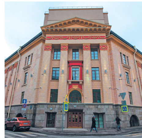
Административное здание ООО «КИРИШИАВТОСЕРВИС» в Санкт-Петербурге
